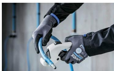
1. Cortar con las pinzas para dos orejas la abrazadera a lo ancho.
