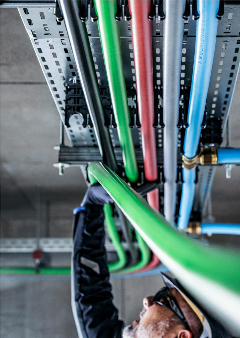
Debido a la rosca externa recubierta de teflón en las piezas nuevas no es necesario el uso de selladores. Para el apriete se requiere una llave de tuercas.
